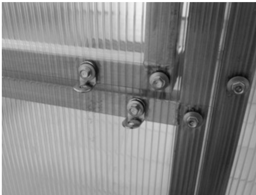
Рис. 11. Места крепления уголков форточки и двери
