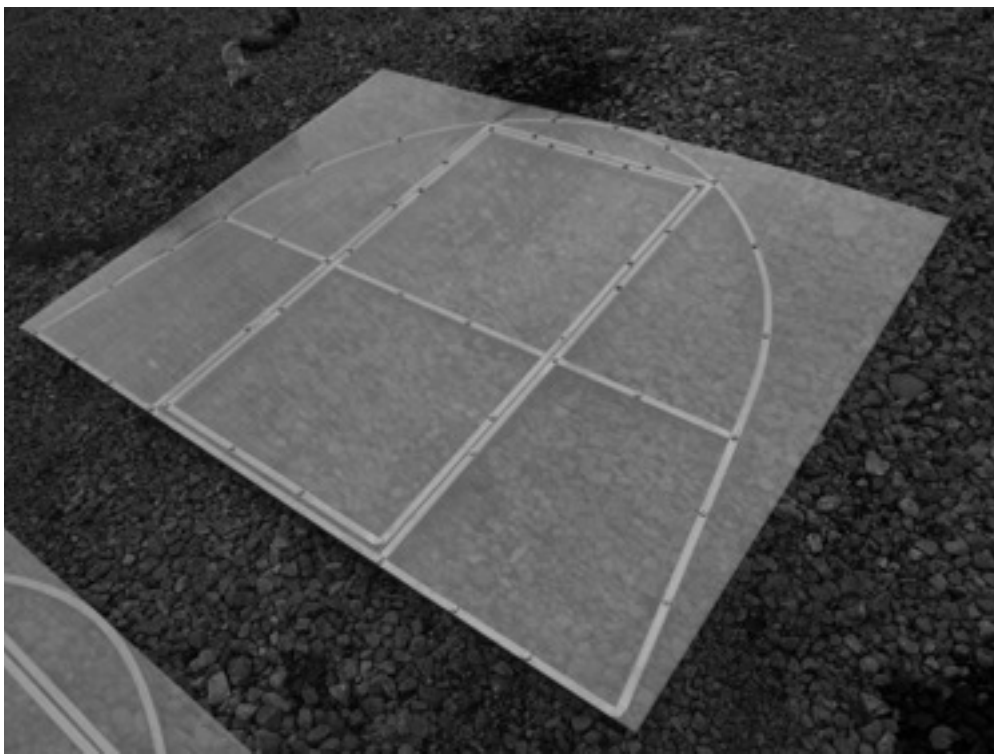
Рис. 6 Крепление листа саморезами
