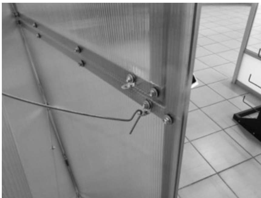
Рис. 13. Проверка фиксации крючка
