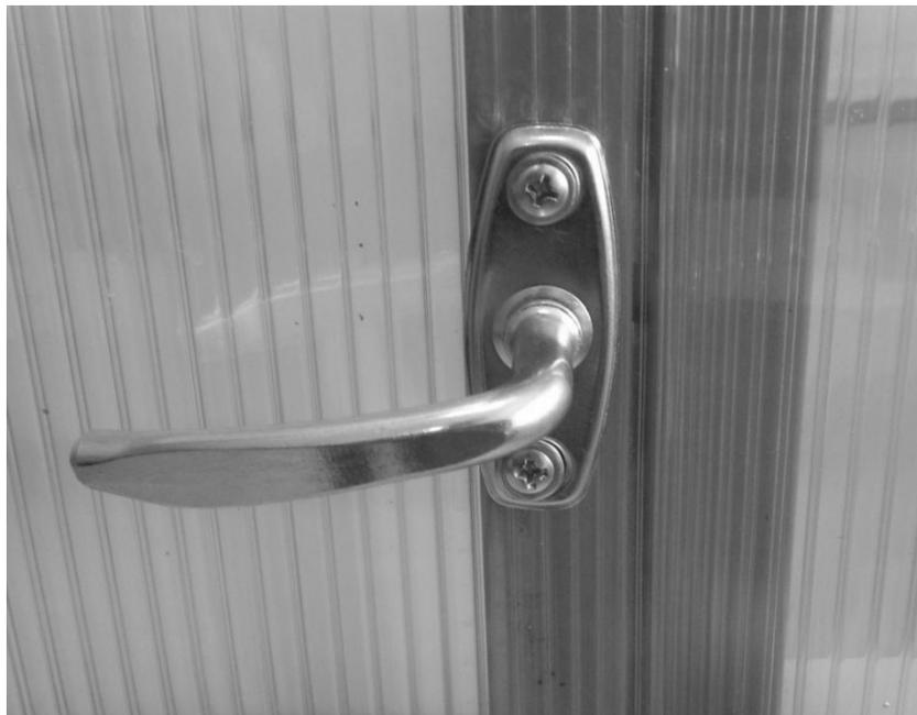
**Рис. 7. Крепление ручки саморезами**
