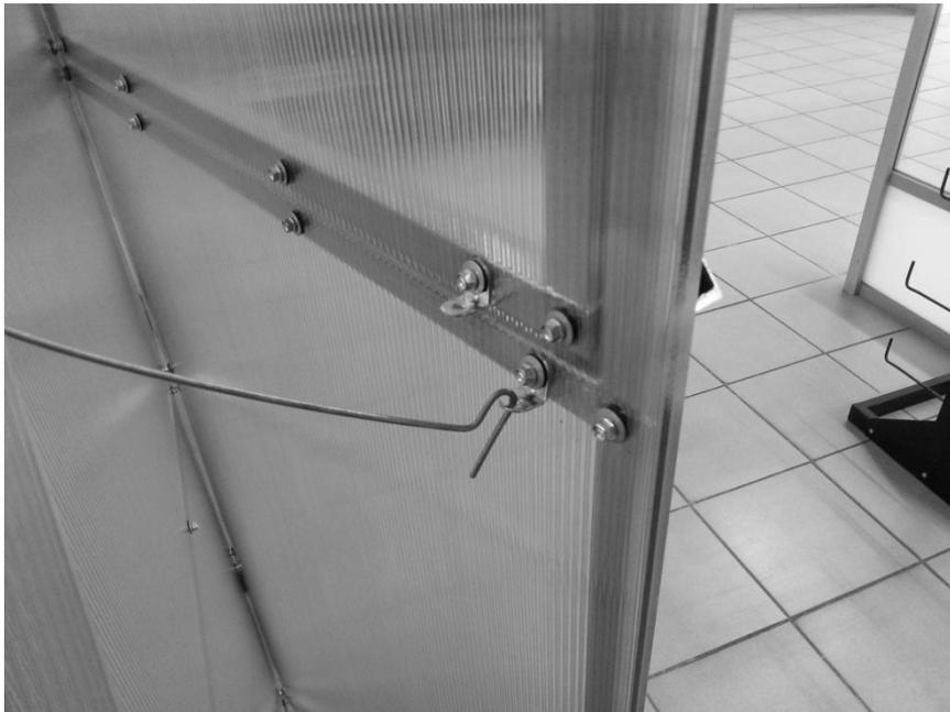
**Рис. 12. Проверка фиксации крючка**
